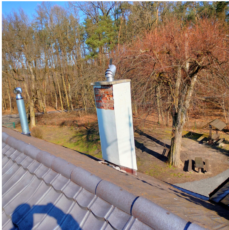
Odpadający tynk z kominów
